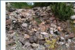
Four à chaux (en ruine)
