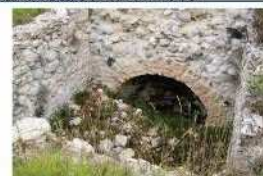
Four à chaux (Maro)
